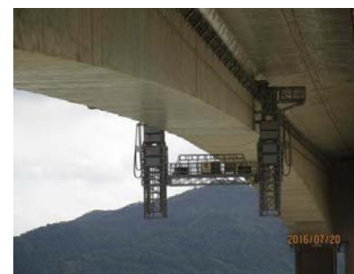
变高度梁底检查车
