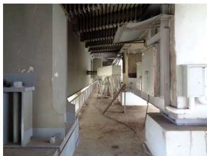
大位移伸缩缝检修通道
