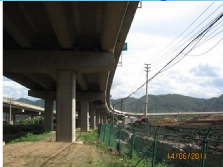
桥梁内侧现状
