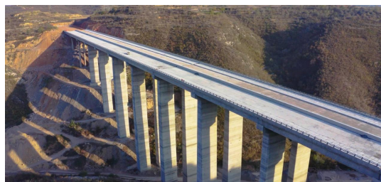
龙川工业园区 2#大桥
