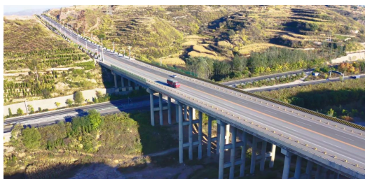
龙川工业园区 1#大桥
